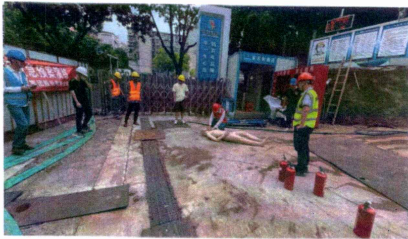
工地地表硬化以及排水汇集沟
