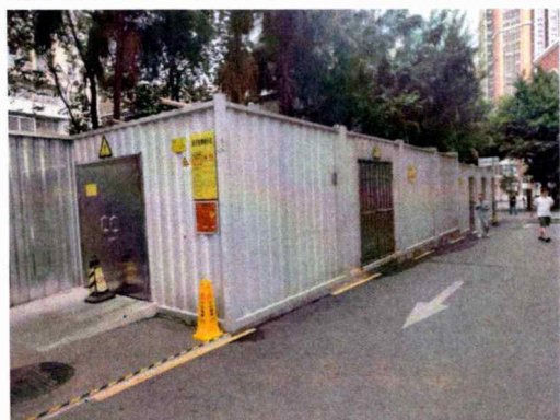
医疗废物临时储存点外观
