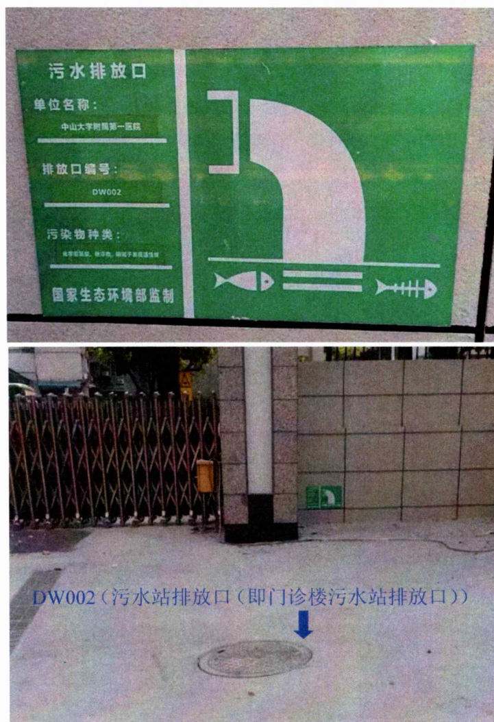
图 9-2.2 排污口规范化现场实拍图
