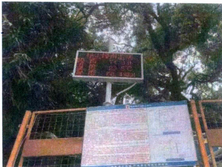
施工噪声、扬尘监测指示
