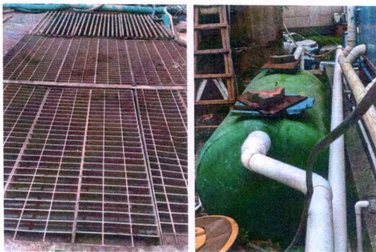
三级沉淀池、化粪池预处理
