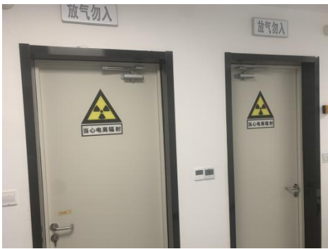
控制室门自动闭门装置
