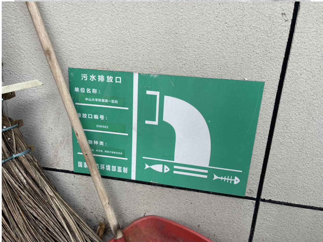
图 10-2 DW002 生活污水排放口及标志牌照片
