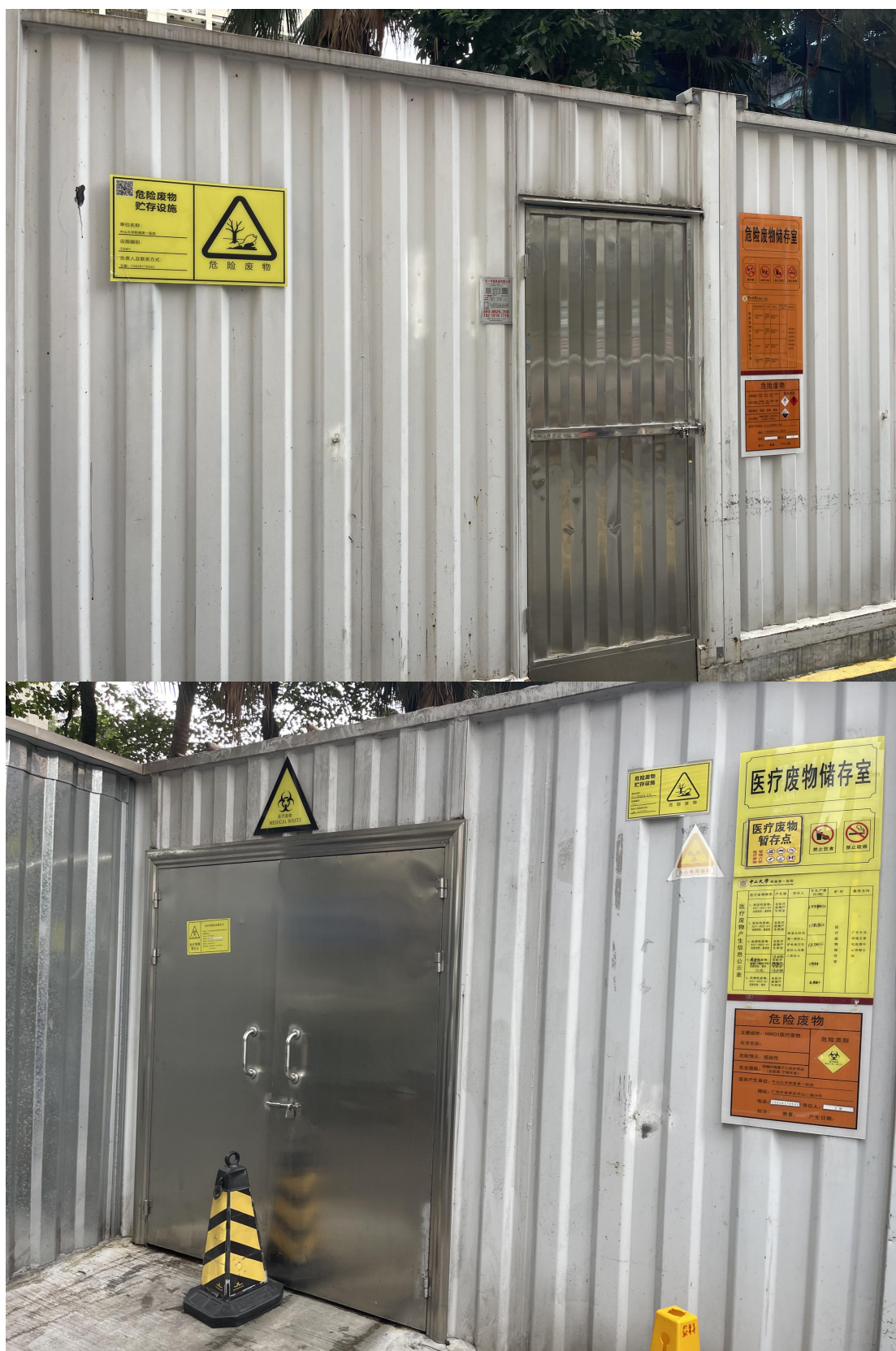
图 10-3 危险废物暂存间、医疗废物暂存间照片
