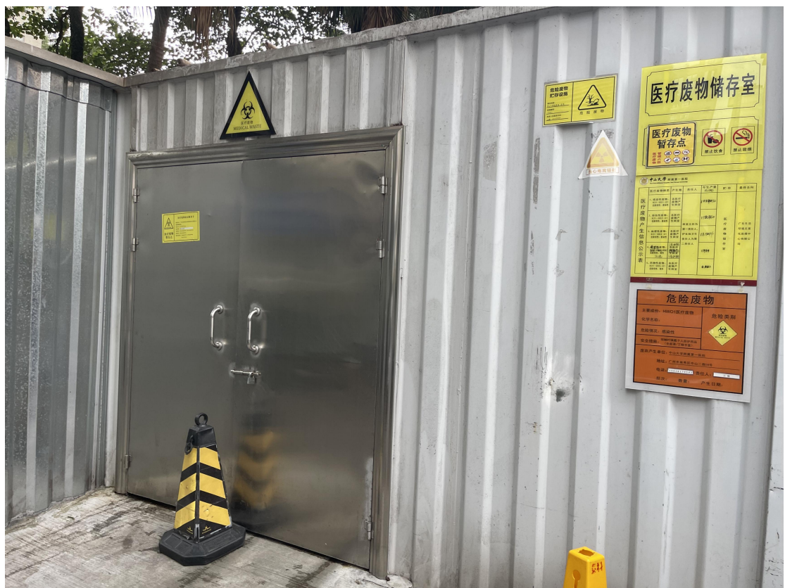
图 5-7 医疗废物暂存间照片
