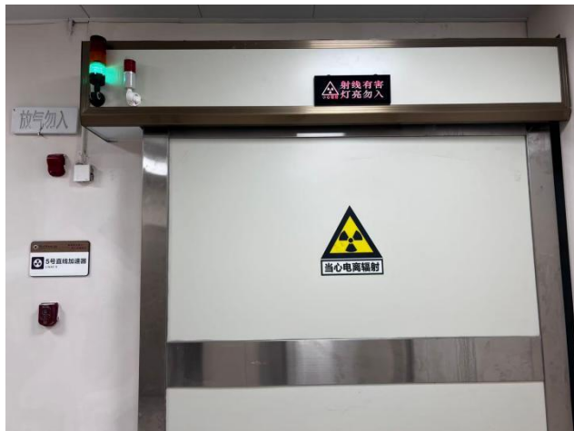
5号直线加速器机房大门
