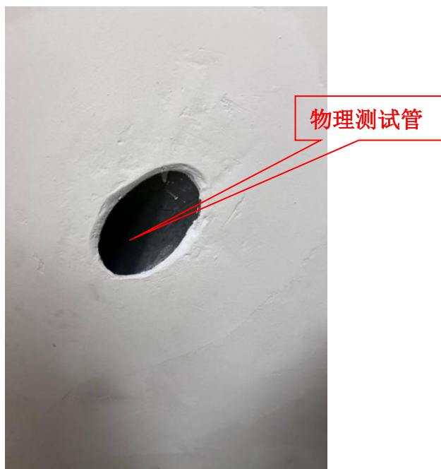
3-8 管线穿墙方式现场照片
