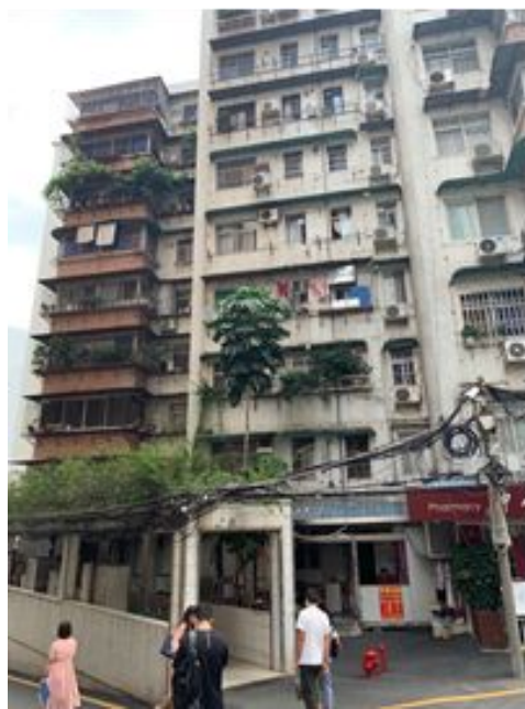
何善衡楼拟建项目东侧
