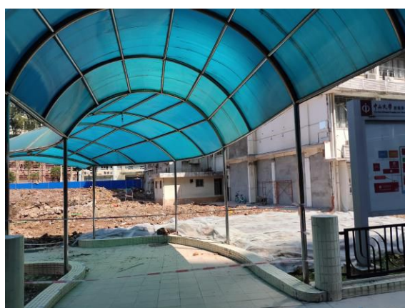
门急诊大楼北侧
