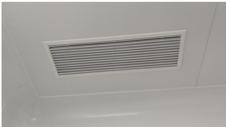
8 号楼 1 层 3 号手术室
